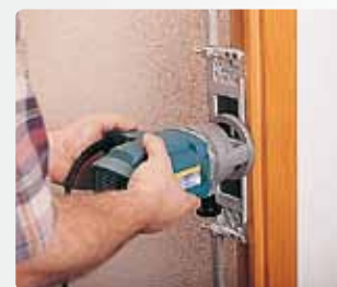
Montaż zawiasów z głowicą CPN66.
