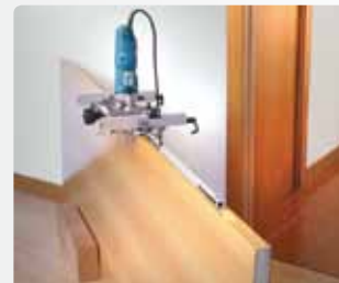
Nie trzeba ponownie ustawiać urządzenia aby wykonać wgłębienia po przeciwnej stronie.
