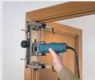
Wykonanie wgłębienia w górnej części ramy.
